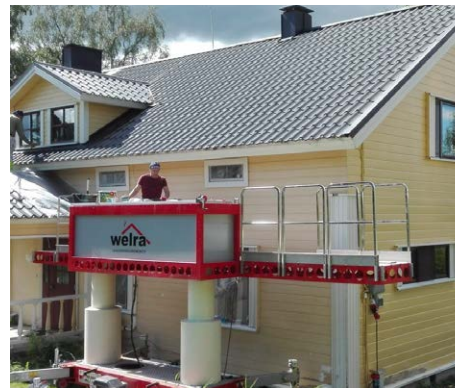
Rapu-työasema liikkuu omilla pyörillään, ja se on uskomattoman kevyt
